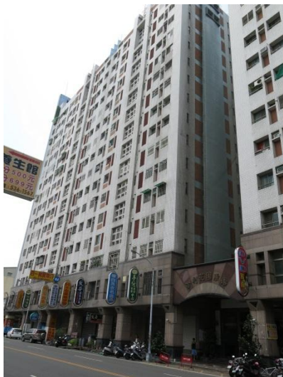
建物正面立面
