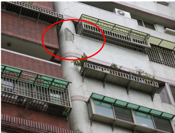
圓柱表面有裂縫及整片剝落
