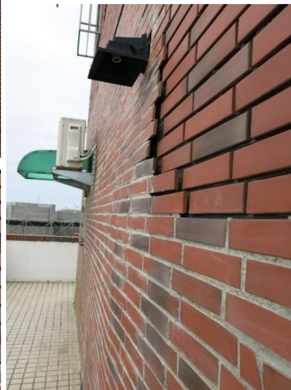
磁磚整片與牆面剝離
