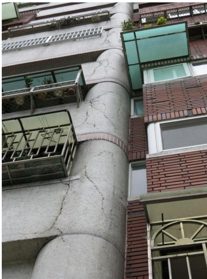
圓柱表面有裂縫及整片剝落
