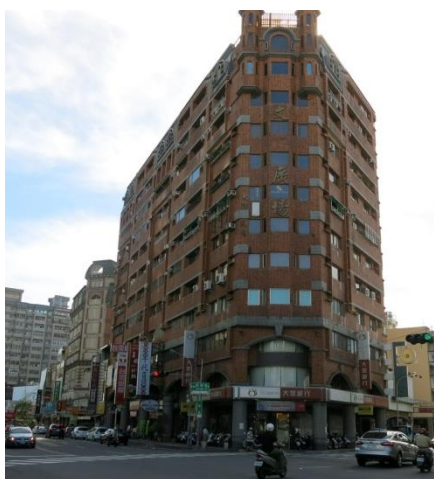
建物正面立面
