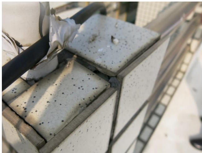
頂樓女兒牆及欄杆周圍已有磁磚掉落及剝離情況
