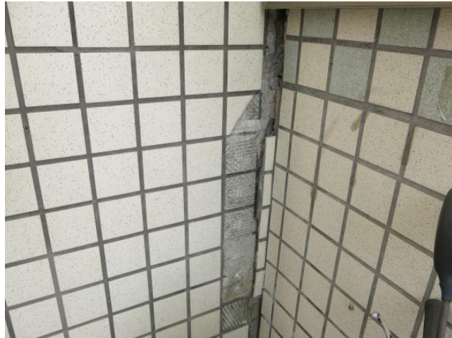
建物外牆磁磚掉落
