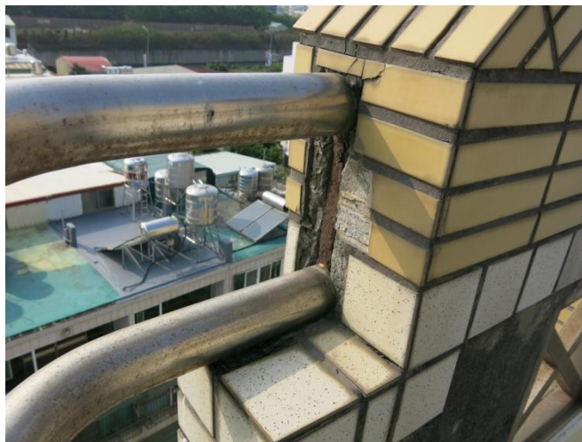
頂樓女兒牆及欄杆周圍已有磁磚掉落及剝離情況
