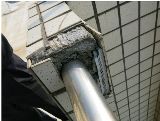
頂樓女兒牆及欄杆周圍已有磁磚掉落及剝離情況
