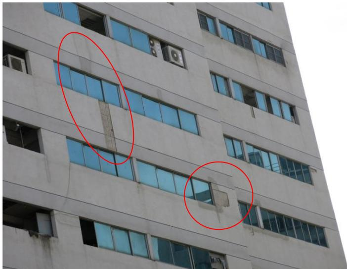
建物外牆多處局部磁磚掉落
