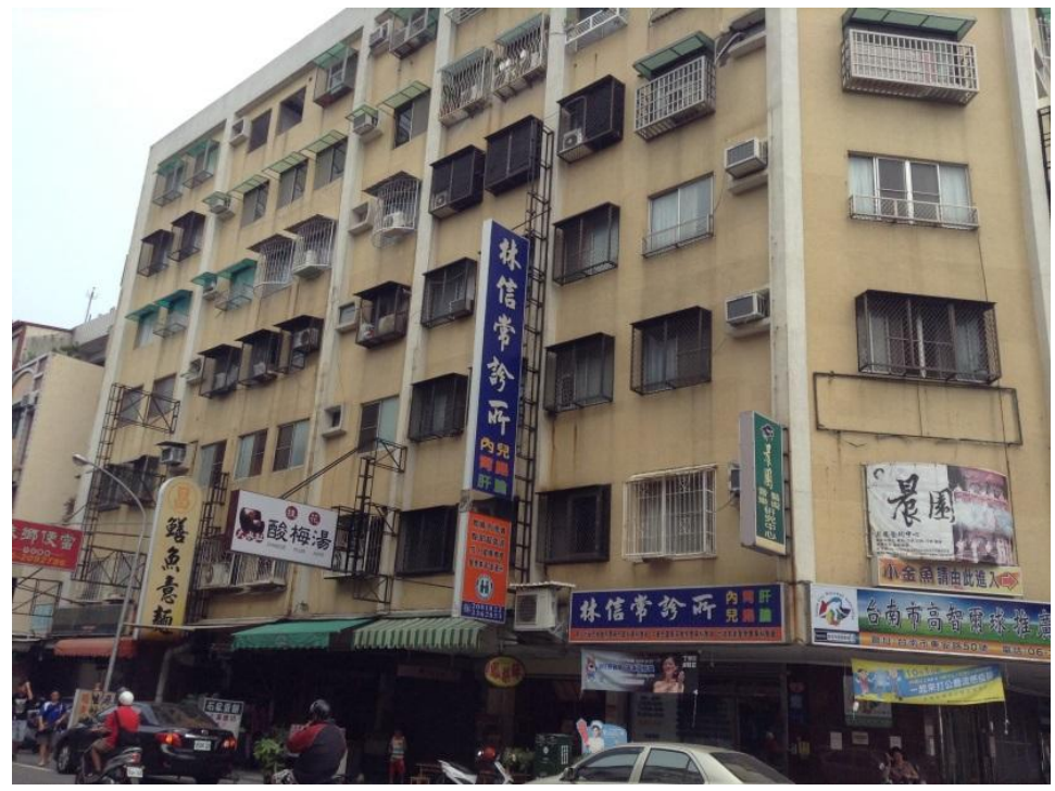
建物正面立面
