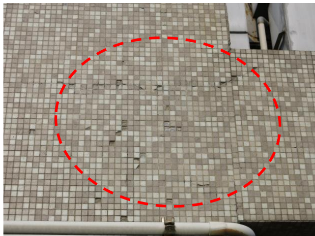
建物外牆多處馬賽克磁磚剝落
