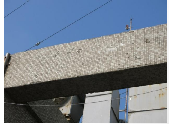
頂樓外牆及女兒牆面部分有裂痕及馬賽克磁磚掉落情形
