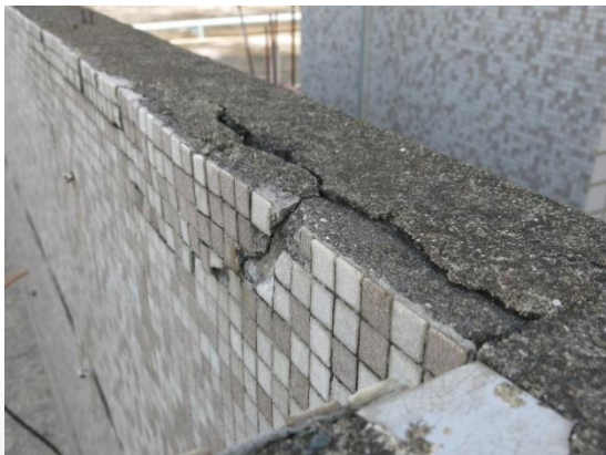
頂樓外牆及女兒牆面部分有裂痕及馬賽克磁磚掉落情形
