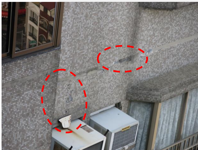
部分牆面出現裂縫、滲漏水情形
