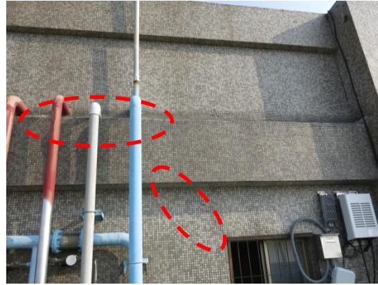
頂樓外牆及女兒牆面部分有裂痕及馬賽克磁磚掉落情形
