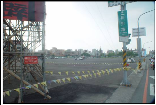
2. 大部分建物已拆除
