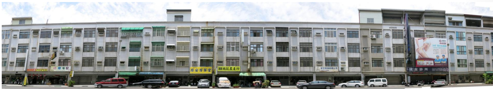
建物正面立面
