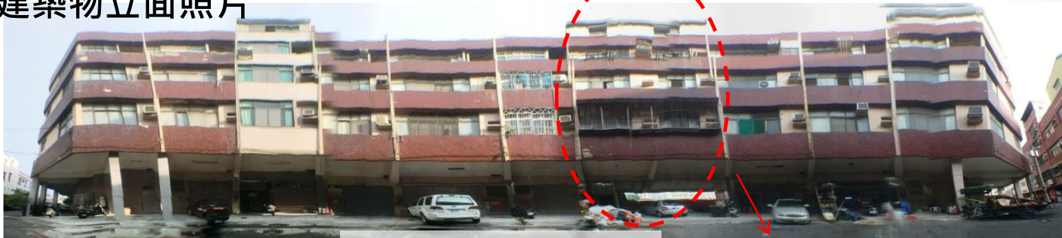
建築物北側(2-1~2-9) 原屬公寓部分(2號2樓之7、2號3樓之7、2號4樓之7)
