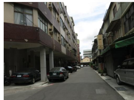
②長東路103巷(建築物北側)
