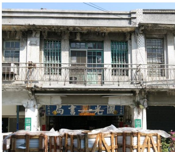
露臺欄杆與門窗破損壞等情形
