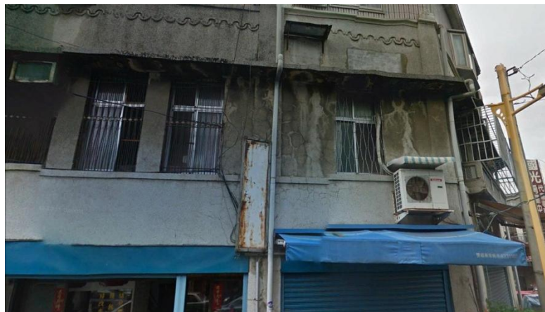
外牆髒汙、牆面龜裂、水泥剝落
