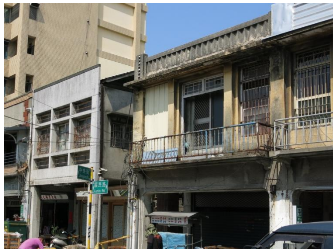
露臺欄杆與門窗破損壞等情形
