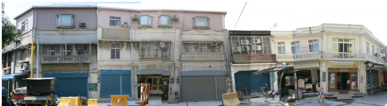
建物正面立面
