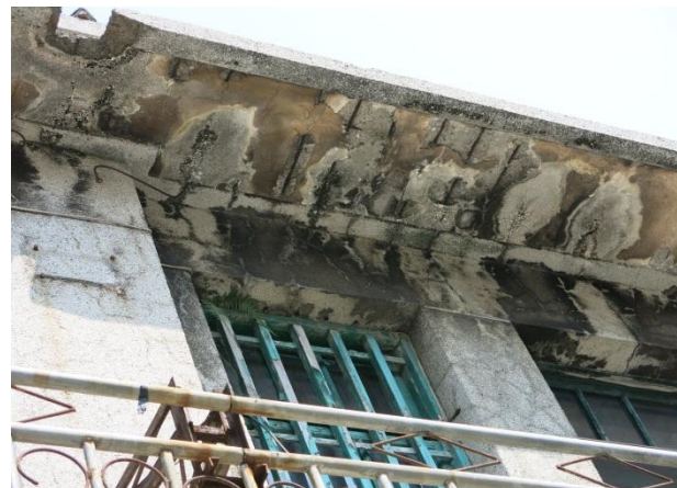
外牆髒汙、牆面龜裂、水泥剝落
